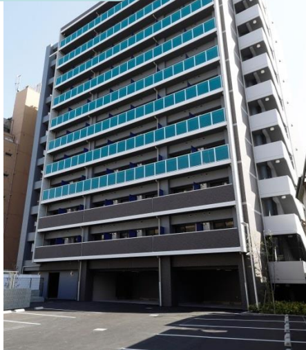
S-RESIDENCE新大阪Garden 大阪市淀川区 177戸 2018年2月竣工
