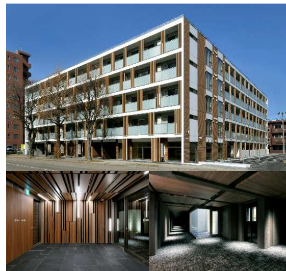
S-RESIDENCE桑園EAST (札幌市中央区)
